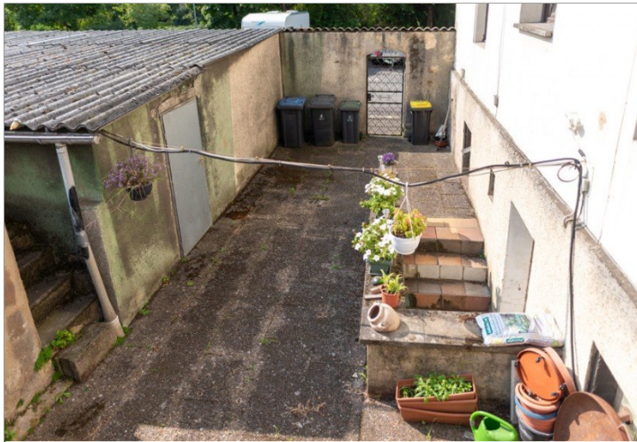
Blick in den Hof mit Zugang zur Garage
