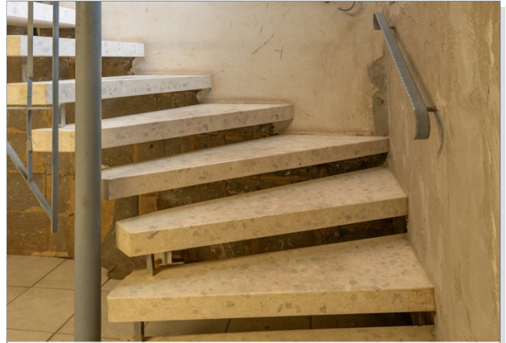
Natursteintreppe in den Keller
