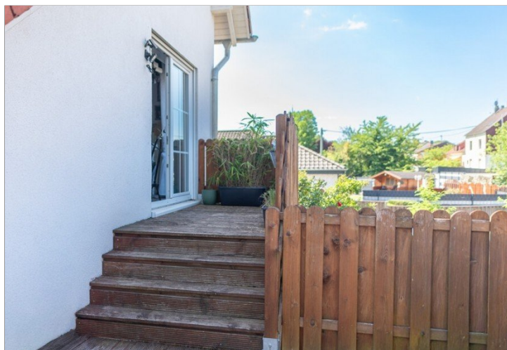
Zugang zur Dachterrasse
